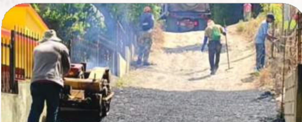
El alcalde Pedro Estrella inició la pavimentación del Kilombo y anunció la construcción de badenes para el desagüe. Los trabajos continuarán hasta completar toda la comunidad. Agradeció al Ministerio de Obras Públicas por su apoyo.
