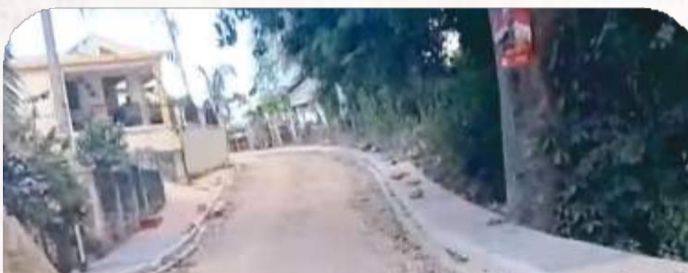
Alcalde Pedro Estrella sigue sus trabajos para el desarrollo de San Víctor. En la comunidad de Las Amapolas construye aceras y contenes y aplica relleno al camino Los Rosario, para en los días por venir gestionar el asfaltado con el ministerio de Obras Públicas y Comuniones.
